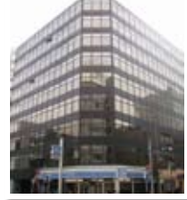
名古屋市中区栄2-5-1宝第一ビル
